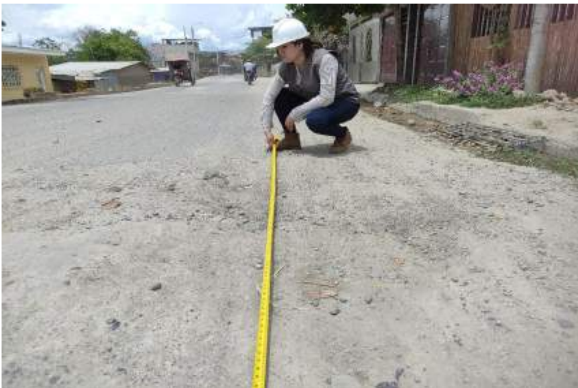
Figura 89. Falla por desprendimiento en la muestra número ocho.
