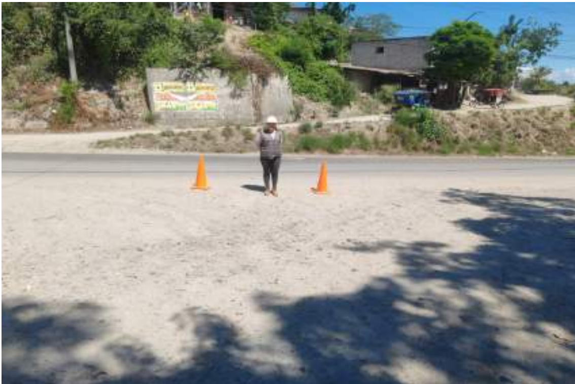
Figura 98. Progresiva 0+000.00 (inicio de la sección del pavimento de la investigación).
