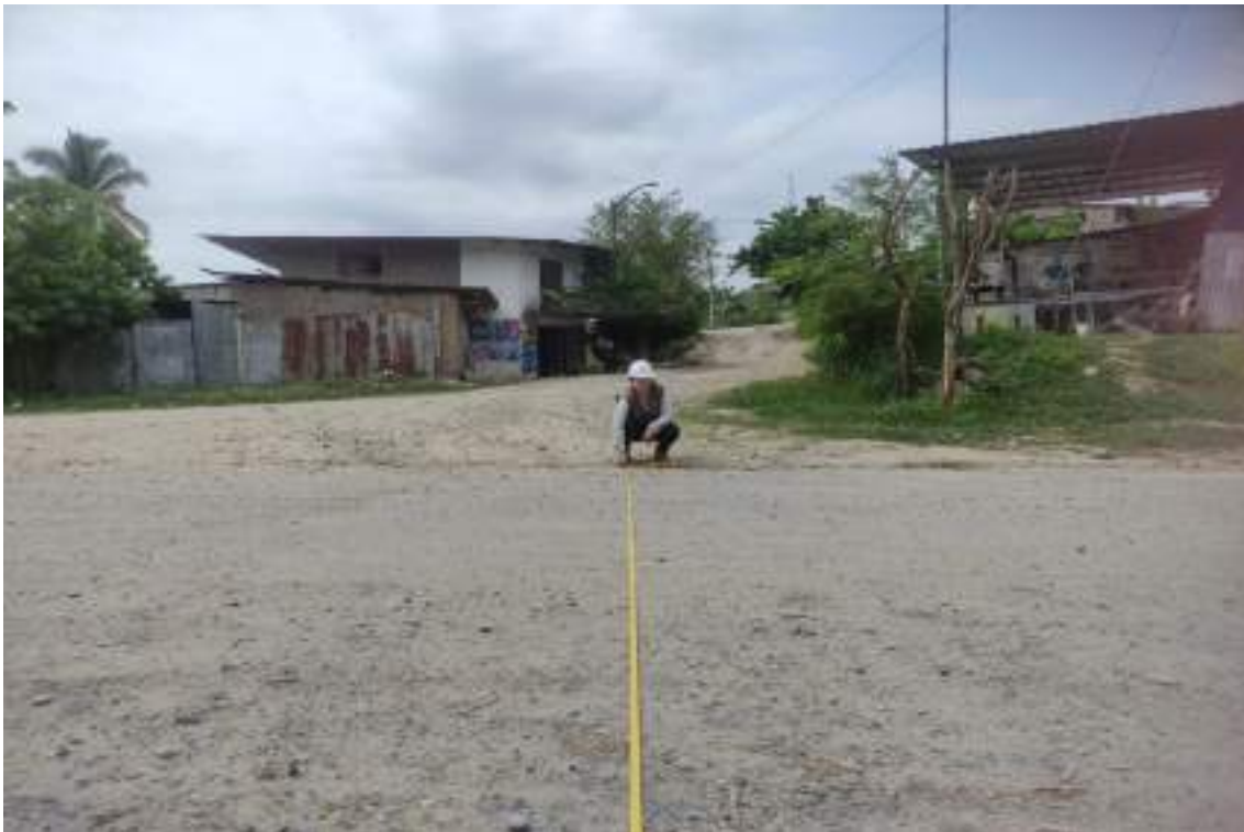
Figura 86. Falla de desprendimiento en la muestra número cinco.
