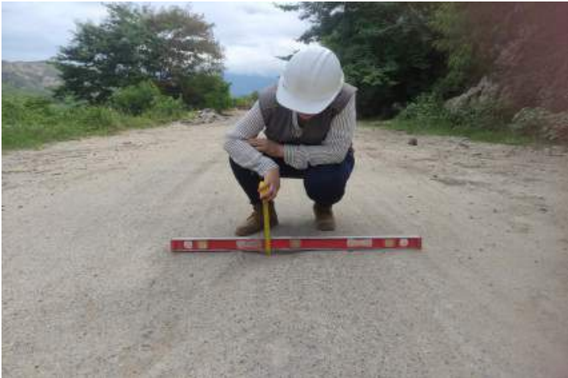
Figura 84. Falla denominada "hueco" en la muestra número tres.
