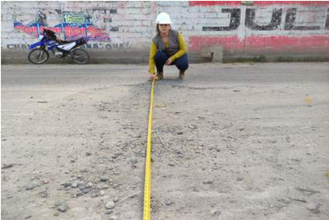
Figura 91. Falla denominada "hueco" en la muestra número diez.
