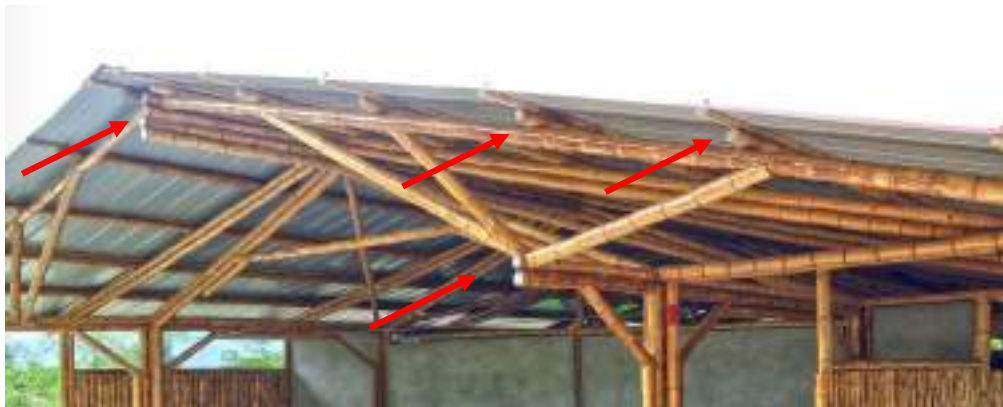
Figura 28. Copa de los culmos sellados con mortero – Uniones con mortero. Fuente: Elaboración propia, fotografía tomada en los Ambientes Académicos, Administrativos y Complementario en el ISTP – Bagua (2022).
