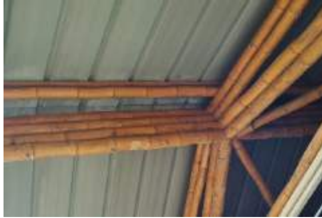
Figura 23. Articulación con 4 culmos - Unión con pernos
