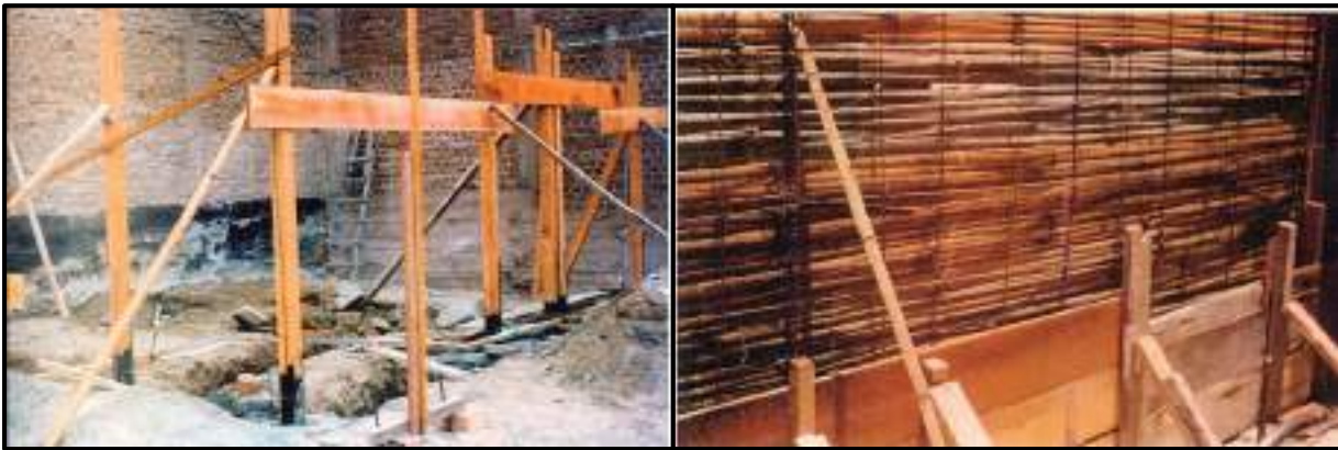
Figura 3. Prototipo de vivienda bajo el sistema cañacreto
