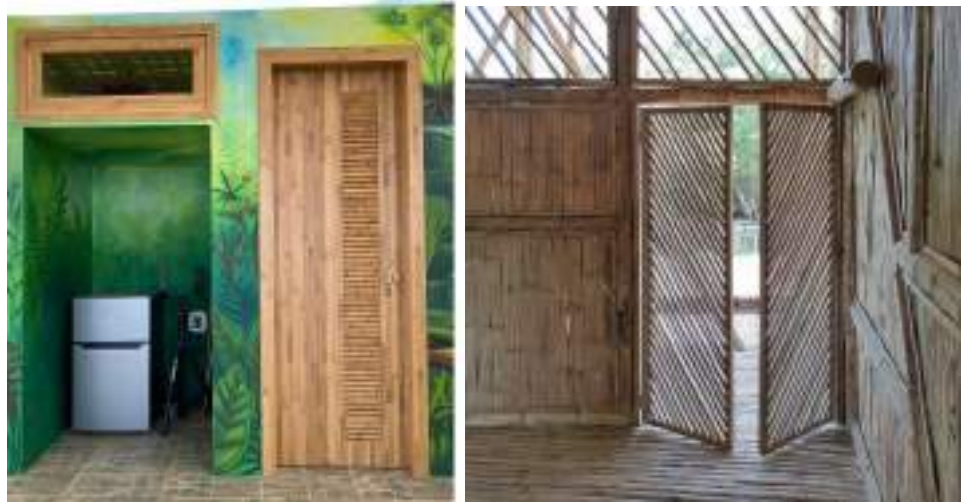
Figura 28. Modelos de puertas de bambú con latillas
