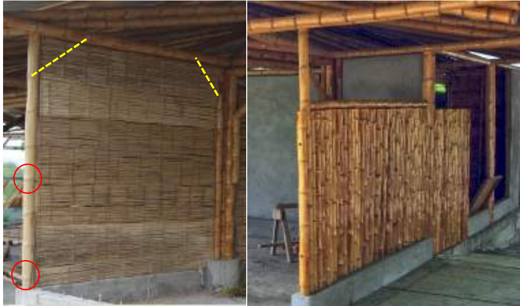
Figura 25. Paneles fijados con pernos.
