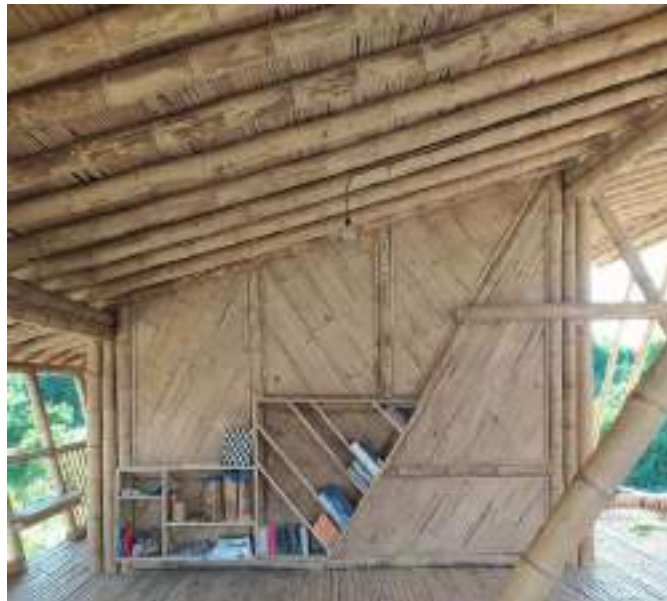
Figura 24. Panel no portante de bambú.
