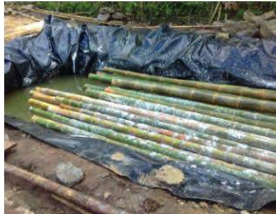
Figura 09. Cañas en proceso de preservación
