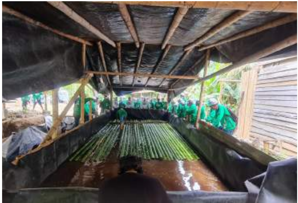
Figura 05. Pozo artesanal para preservado de bambú.
