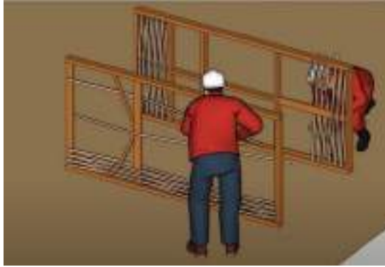
Figura 12. Proceso constructivo de quincha prefabricada.
