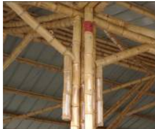
Figura 32. Uso del Corte tipo Boca de Pescado en el ISPT.
