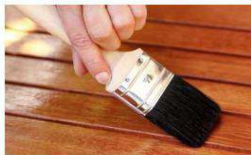
Aplicación de barniz con brocha
