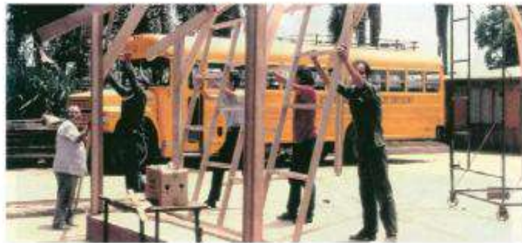
Montaje de paredes sin revestimiento
