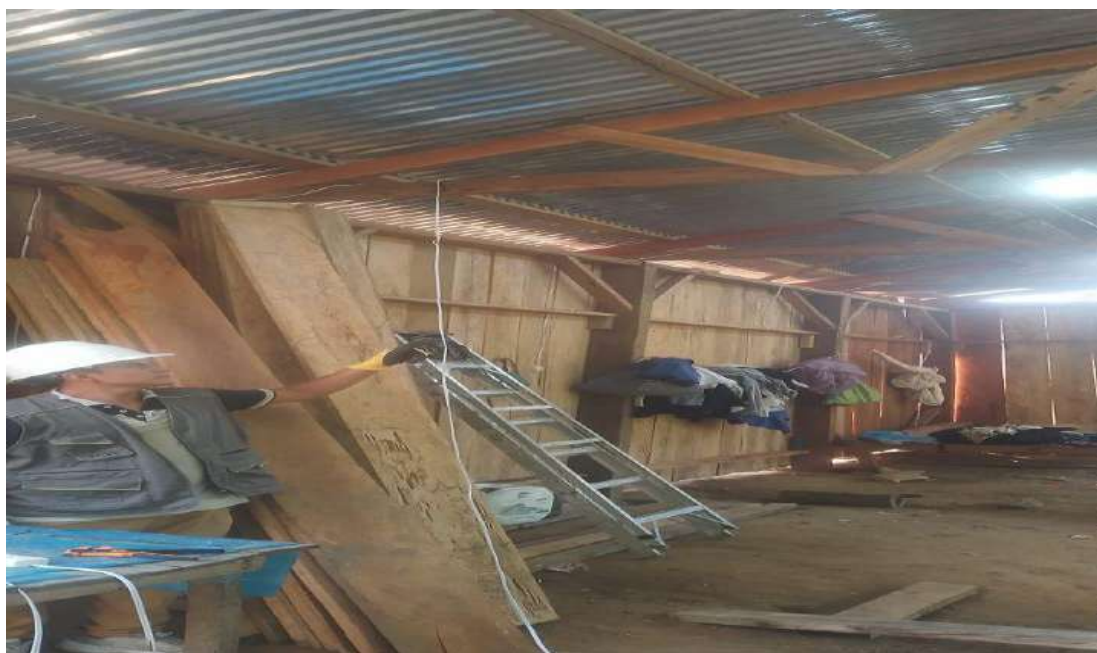
Instalación de tablonos de madera
